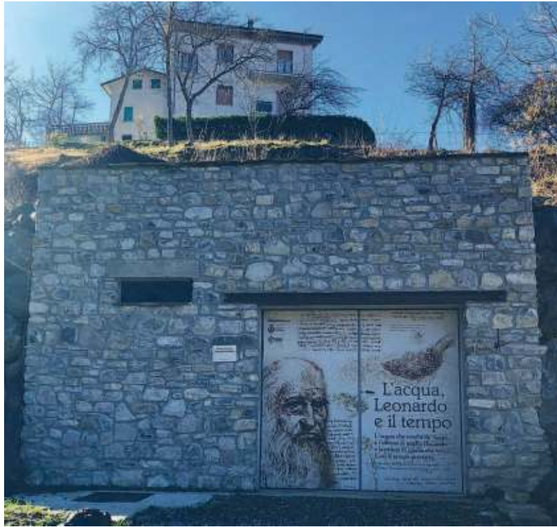
LA CENTRALE IDROELETTRICA DI CERIGNALE
