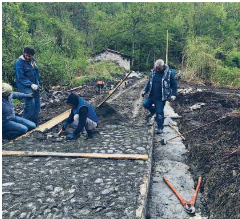
LA STRADA CHE SOVRASTA LA CENTRALE DI CERIGNALE
