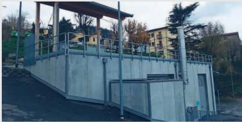
LA CENTRALE TERMICA DI MONZUNO
